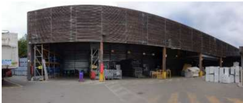
Figure 2 : vue sur le bâtiment de stockage dans son environnement
